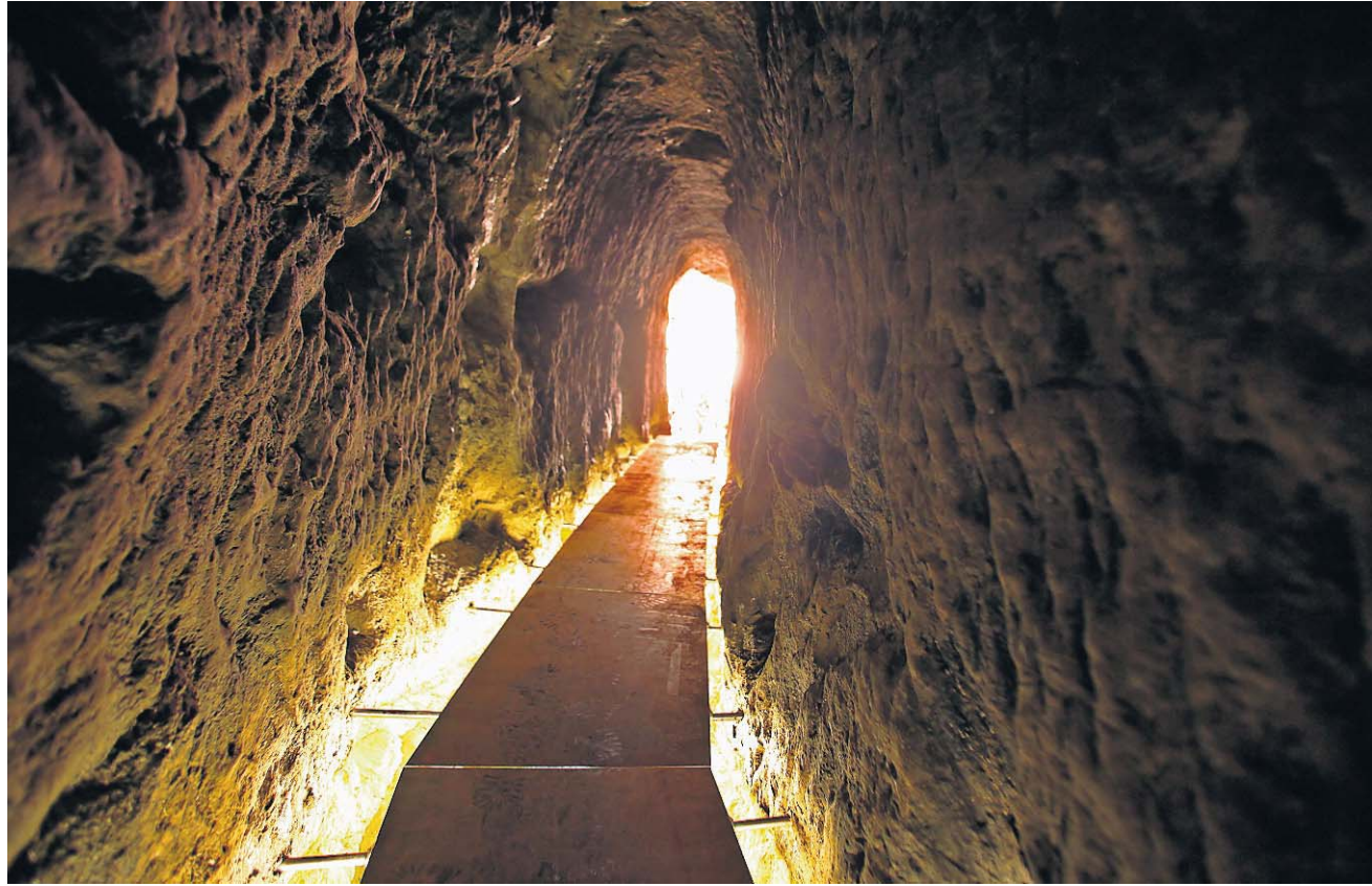
Ein aufregender Blick in die Meyerschen Stollen im Untergrund des neuen Aarauer Bahnhofs. CHRIS ISELI
